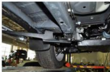
Рис.4 Установка переднего кронштейна
